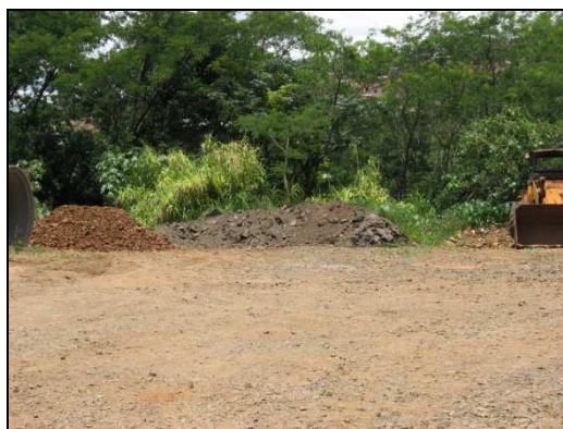
Figura 5.5 – Terreno para locação da EEE A-3 (Rua Governador Jorge Lacerda)
