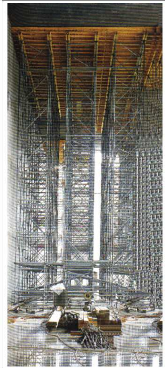
Figura 1.13 - Cimbramentos com torre tubular
