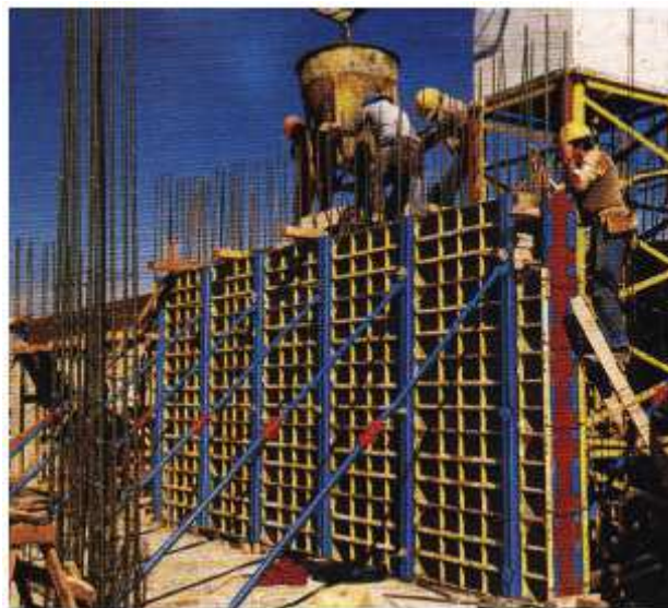
Figura 1.14 - Cimbramentos para formas verticais
