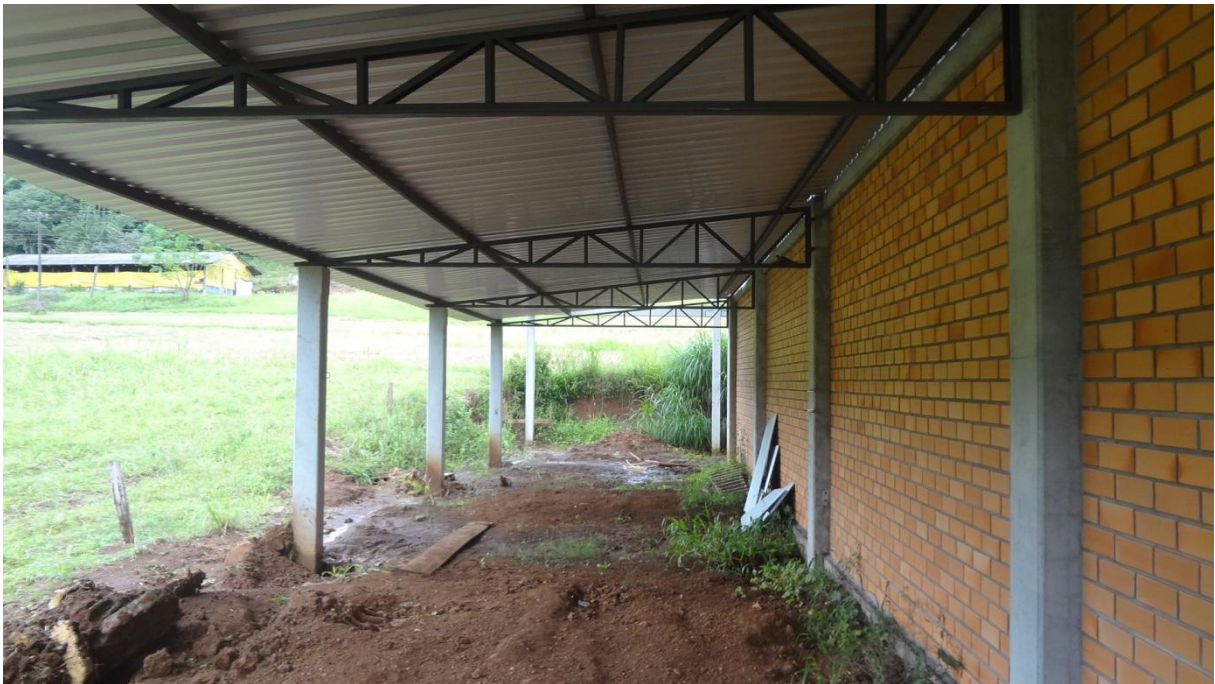
Figura 1 – Cobertura dos banheiros existentes
