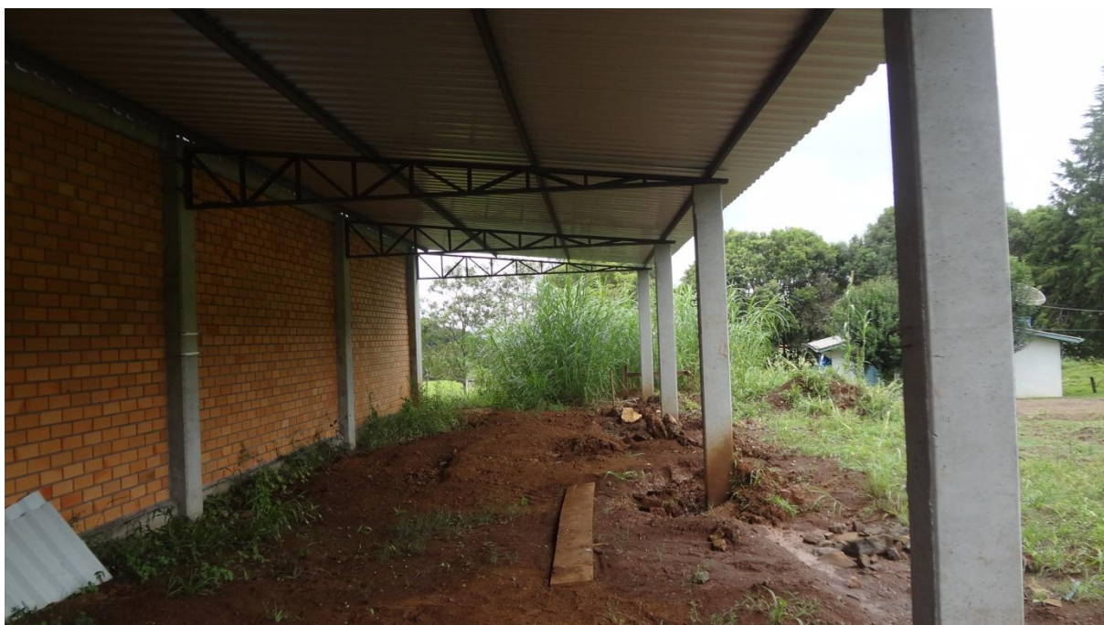
Figura 2 – Local dos Banheiros existente
