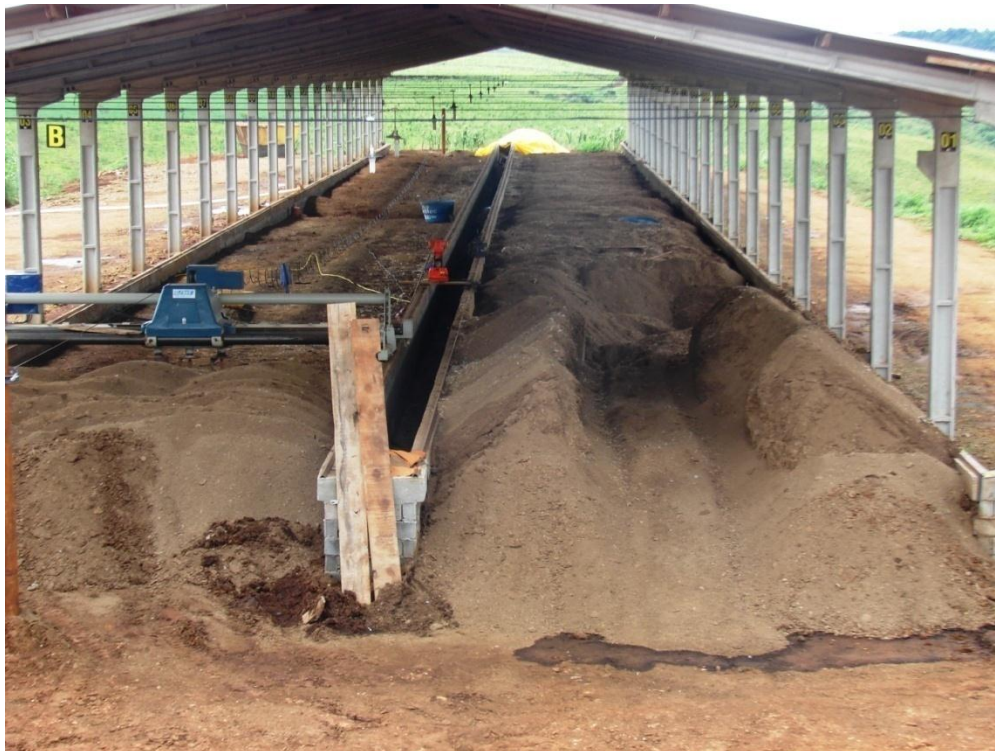
Foto 3.2 – 01 – Detalhe do Local da área de compostagem Chapada Verde- Capinzal – SC
